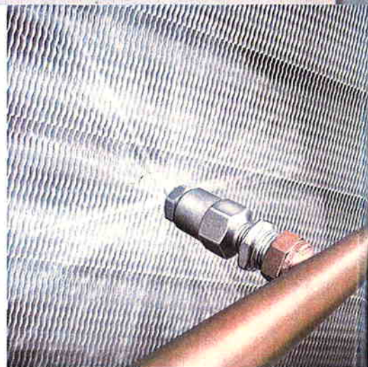
Le rampe sono dotate di ugelli atomizzatori speciali per la distribuzione dell'acqua sull'intera superficie delle batterie.
